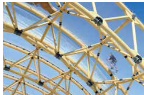
Das Zentrum «Vitam'Parc», Neydens (Frankreich), 2009. Die maximale Spannweite der Zweigelenk-Fachwerkträger beträgt 43 m. (Bild: © Corinne Cuendet, Clarens/LIGNUM)
